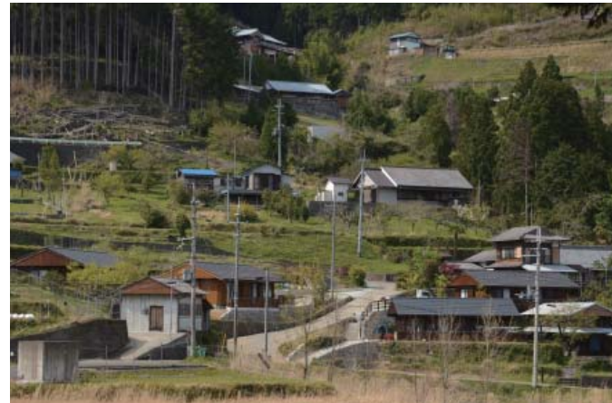
集落に溶け込んだ復興公営住宅（谷瀬集落）
