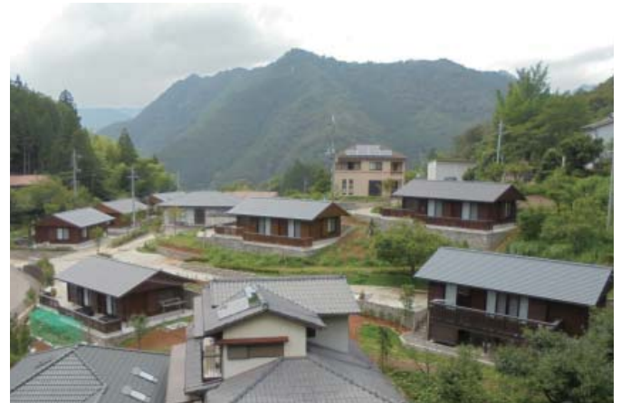
斜面地を活かした復興公営住宅（高森集落）
